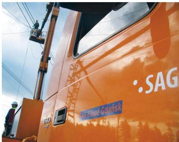
Pracownicy wykonawcy inwestycji - SAG Elbud Gdańsk S.A.
