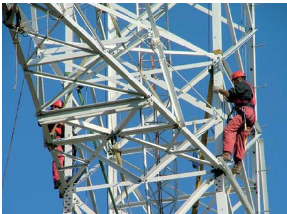
Prace modernizacyjne na linii elektroenergetycznej
